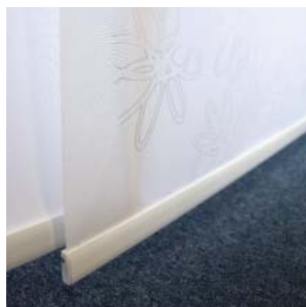
Detail spodní lišty posuvného panelu
